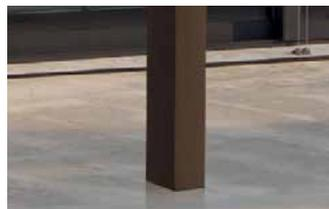
Les pieds en aluminium extrudé de 140 x 140 mm de large et de 2670 mm de haut sont entièrement intégrés aux profils. Aucune vis n'est apparente pour une finition parfaite.
