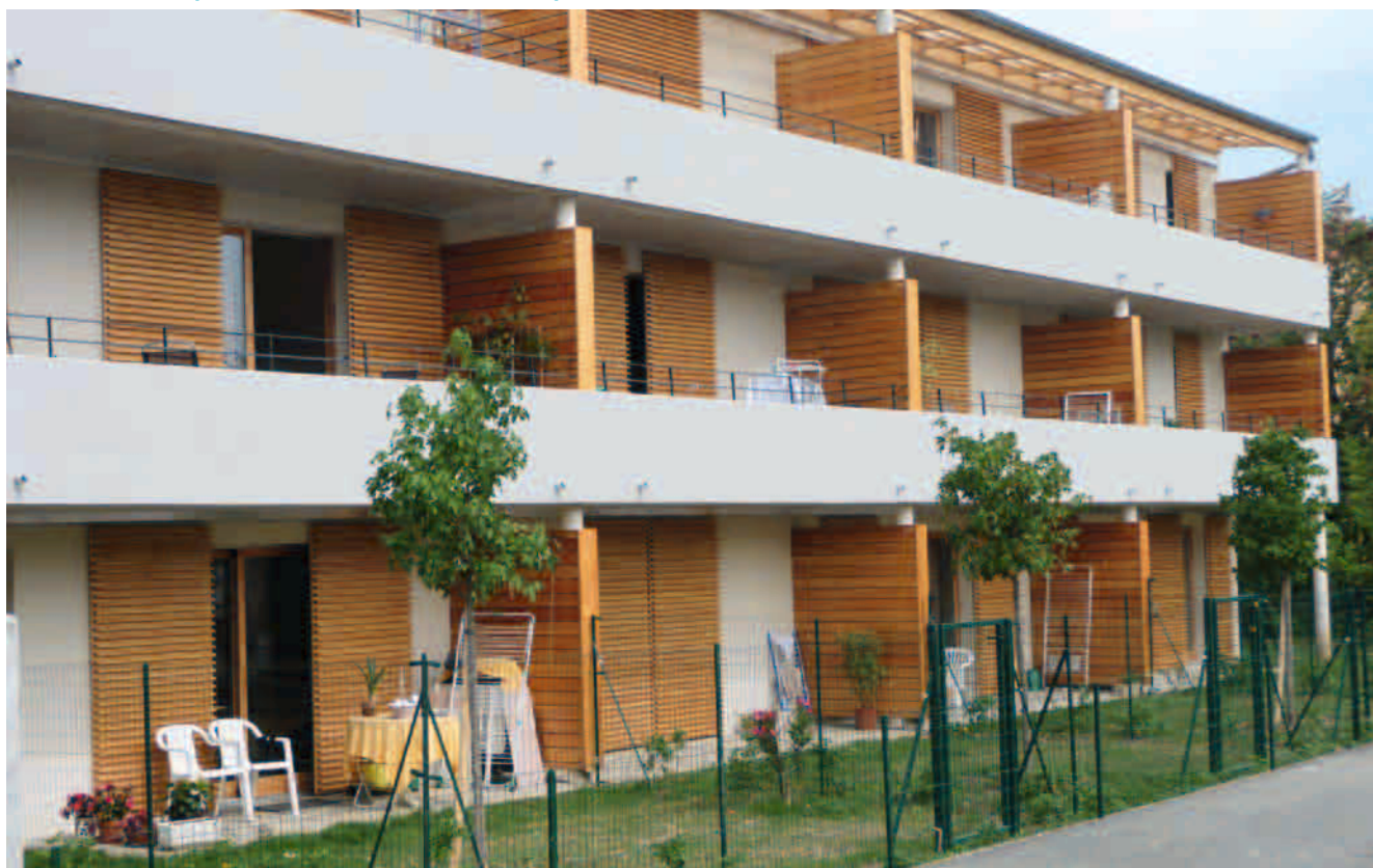
COULISSANT MELEZE avec lames spéciales en forme de trapèze
